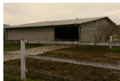
pomožni hlev (objekt št. 35 na parceli 3592/2)
