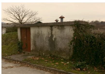
vodno zajetje na parceli (objekt št. 38 na parceli 3592/9)
