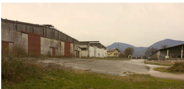
Slika 1: pogled proti severozahodni strani kompleksa
